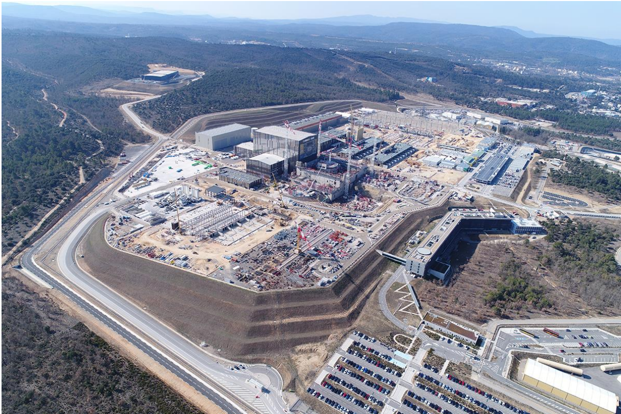
5.9. ábra: Épülő fúziós erőmű Dél-Franciaországban (Cadarache)
